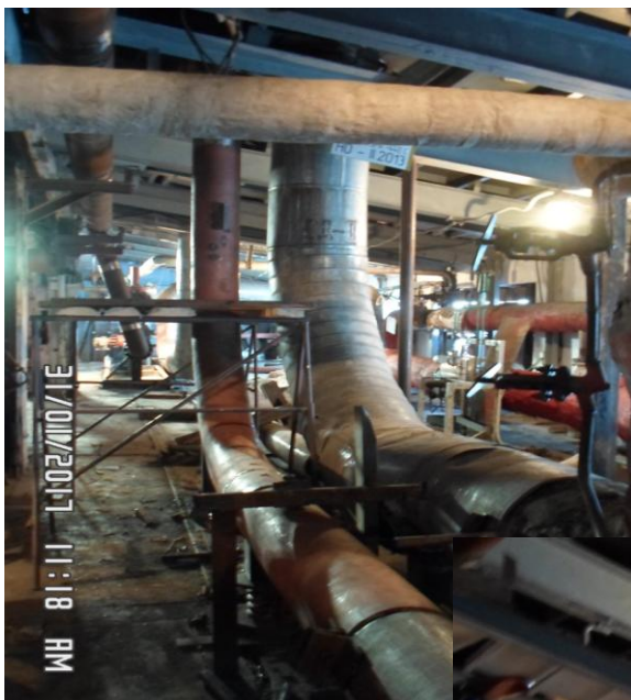
Фото 1 – Паропровод (участок на отметке +15.500)
