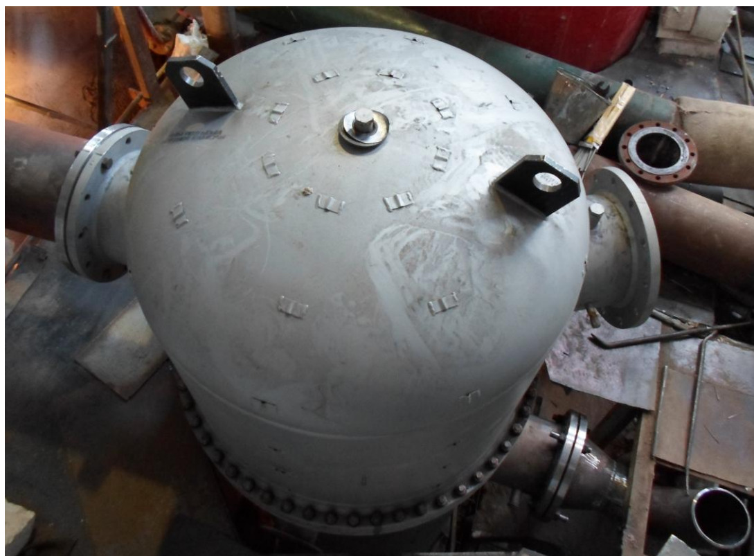
Фото 6.2 – Монтаж ПСВ-200 в бойлерной ТЭЦ
