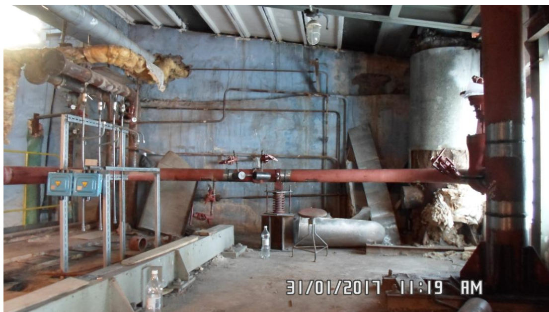
Фото 3. – Паропровод и стенд датчиков РОУ-2.
